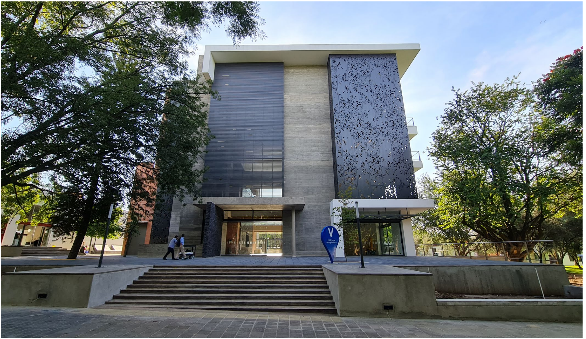
Vista ingreso poniente
